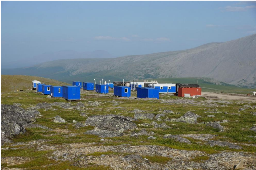
Фото 192. Новая база 21_18_37_48_DSC07437
